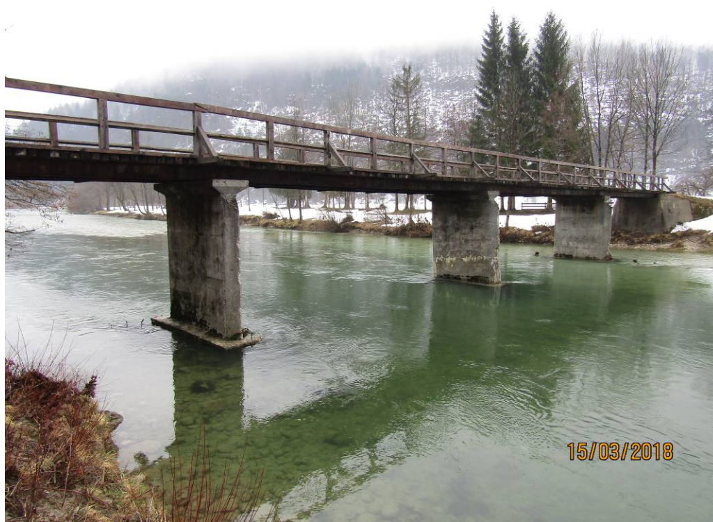
Slika 1: Pogled na most - spodnja konstrukcija - dislocirani steber v osi 3
