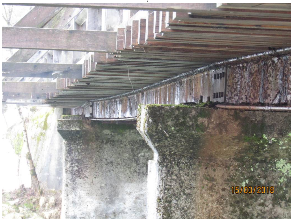
Slika 7: Vzdolžni primarni jekleni nosilci
