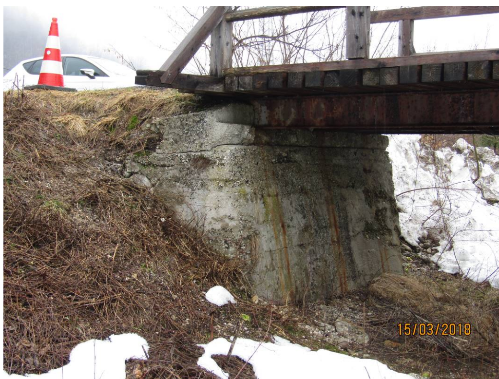
Slika 6: Krajni opornik - levi breg
