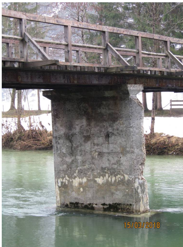
Slika 3: Dislocirani steber v osi 3, ki se zamenja
