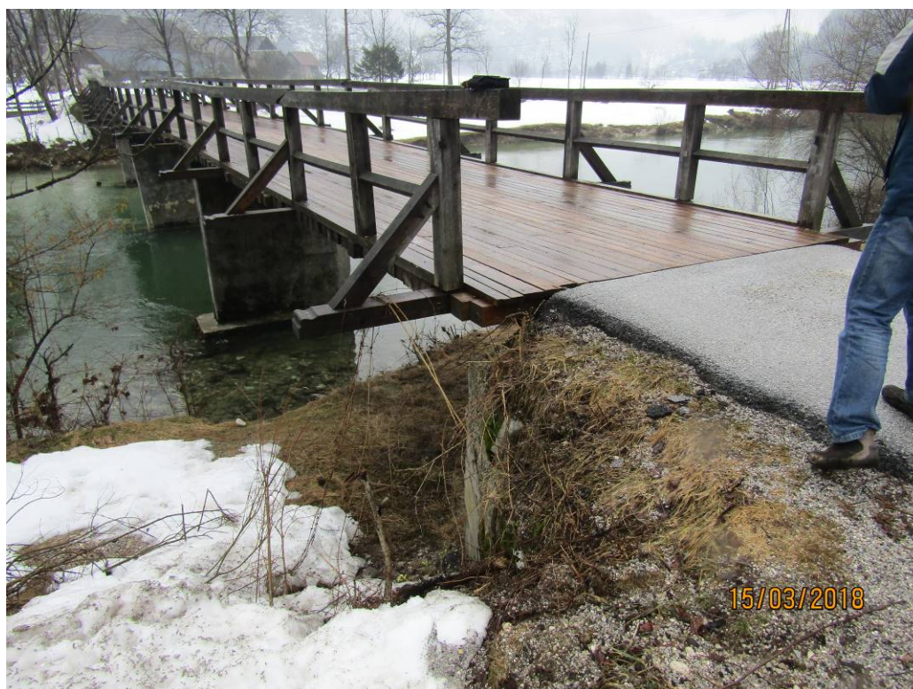
Slika 2: Pogled na most - zgornja lesena konstrukcija
