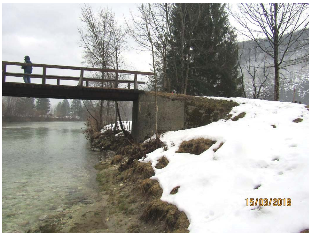
Slika 5: Krajni opornik - desni breg
